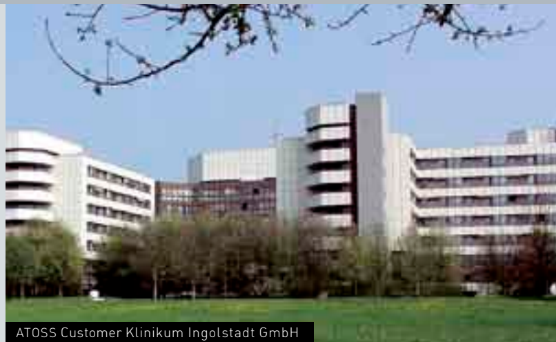
ATOSS Customer Klinikum Ingolstadt GmbH
